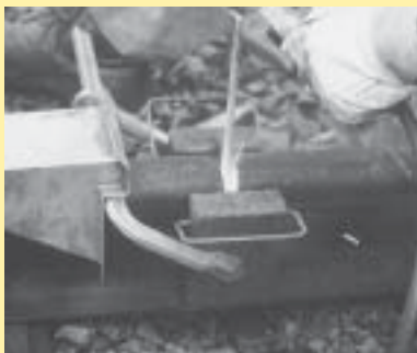
Kiskojen hitsaus muottihitsauksena: OK 74.78.
