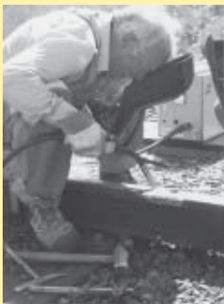
Kiskon pinnan korjaushitsaus OK Tubrodur 15.43.
