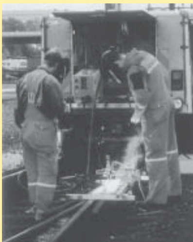
Mekanisoitua hitsausta: Railtrac BV/OK Tubrodur 15.43.
