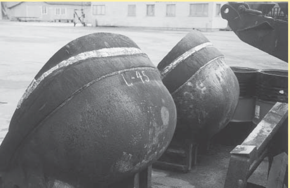
Ruoppauskauha. Uusien huulilevyjen kiinnitys puikolla OK 68.82.
