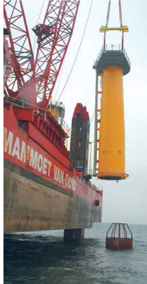
Väliskappaleita asennetaan yksittäisen paalun päälle. Väliskappale on 15 metriä vedenpinnan yläpuolella.
