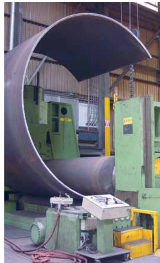
Runkoihin tarkoitetut valssatut levyt. Paalujen valmistuksen ensimmäinen vaihe.
